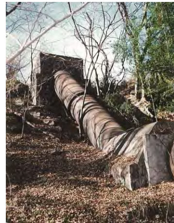
畑山発電所跡
