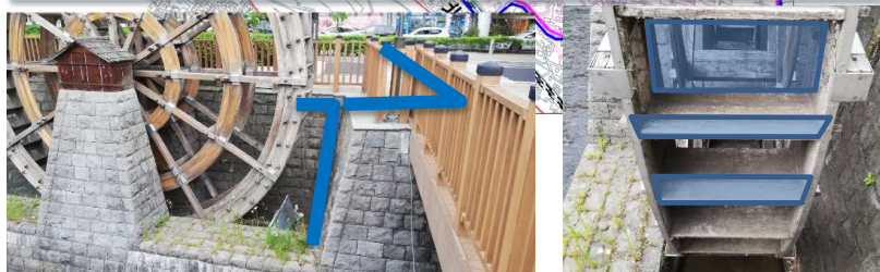
用水引込(夏季)や、水中ポンプ設置(冬季) 水をためられる水受けに改修(棚板、底板)
