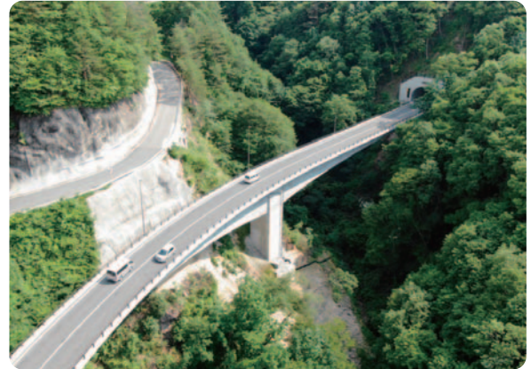
矢越トンネル・滝上大橋 (筑北村)
