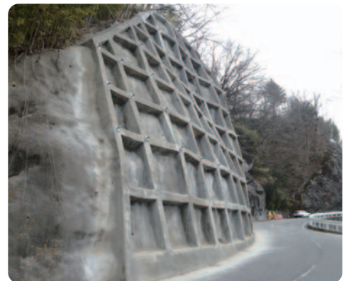
芝平高遠線 のりめん 法面補修工事後 (伊那市)
