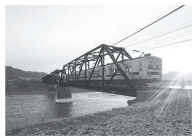
別所線の千曲川橋梁
