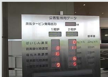
電光掲示板の例 (上越市クリーンセンター)
