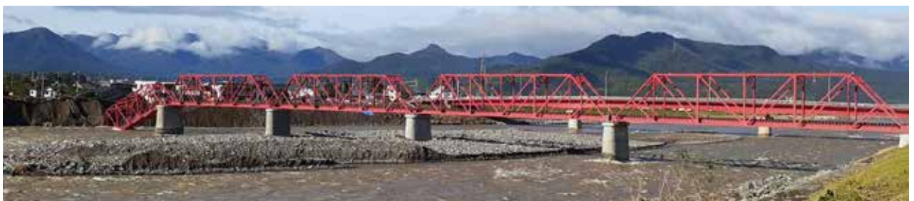
千曲川左岸堤防の欠損と上田電鉄・別所線橋梁の崩落（諏訪形）
