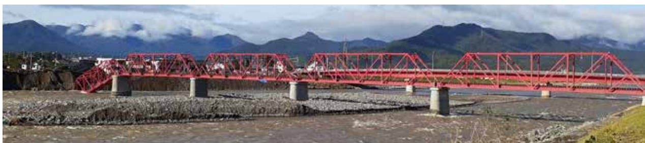
図 2-7 令和元年東日本台風の被害 千曲川左岸堤防の欠損と上田電鉄・別所線橋梁の崩落（諏訪形）
