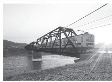
別所線の千曲川橋梁
