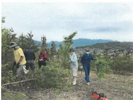
整備作業の様子
