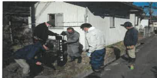
設置作業の様子
