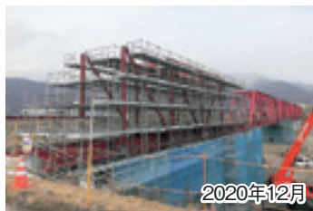
③復旧工事
