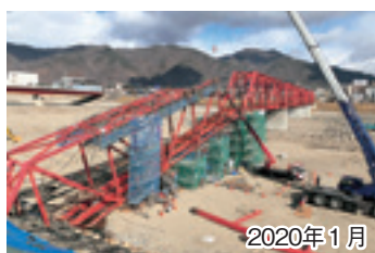
②復旧工事
