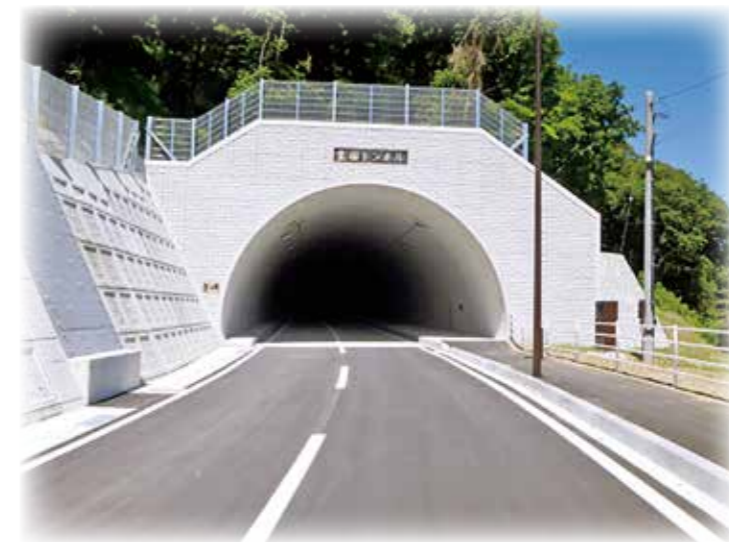
生田トンネル(丸子側)
