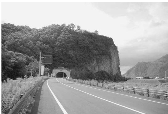
岩鼻トンネル
