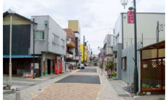
電線類地中化事業（中央地域）
