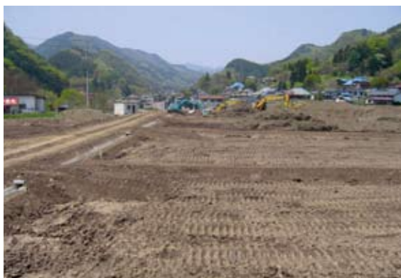
県営中山間地域総合整備事業（ほ場整備の状況）
