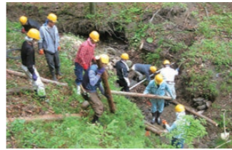
崩落した沢筋に間伐材を使用している様子
