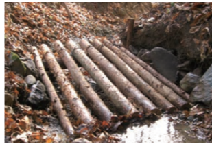
土留めの完成
