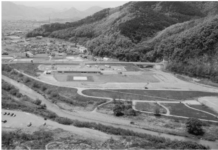
千曲川上空から見た「上田 道と川の駅」
