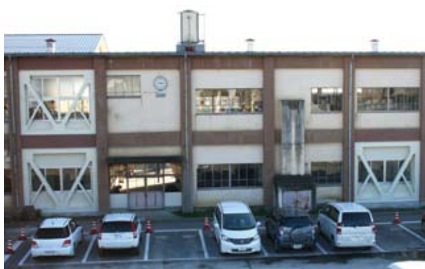
耐震改修した神川小学校 管理特別教室棟
