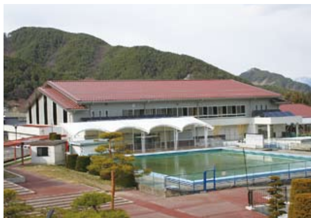
改築した武石小学校屋内運動場
