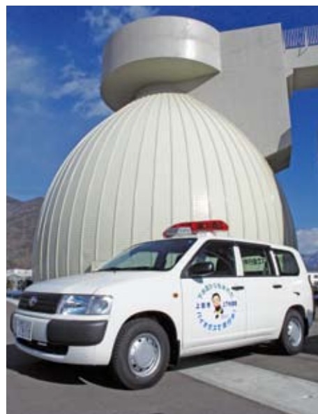
消火タンクとメタンガスで走る車
