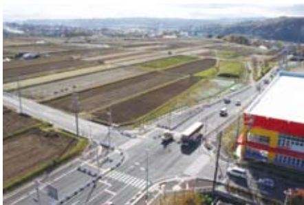
一部が供用開始された上田バイパス第二期工区
