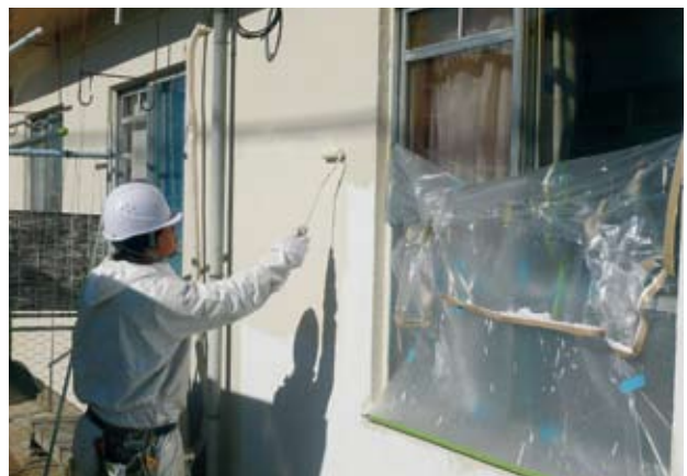
市営住宅の補修作業
