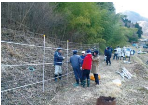
侵入防止柵の設置
