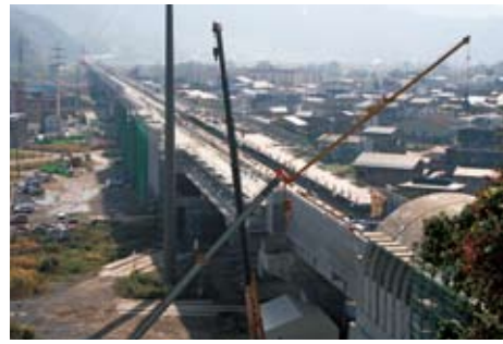
建設工事が進む北陸新幹線（飯山市内）
