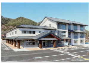
14 武石地域総合センター開所
