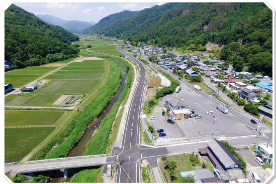
▲国道254号和子バイパス
