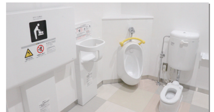
多目的トイレ 1階にオストメイト、2階に子ども用便器を併設しました（1階・2階・3階）
