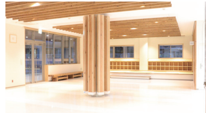
ホワイエ 広々とした談話スペースは、停電時でも自家発電により冷暖房が稼働します
