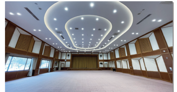
コミュニティホール 旧武石公民館コミュニティホールは解体せず、天井、照明、空調を更新しました
