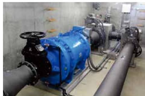
染屋浄水場の小水力発電
