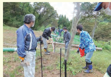
転落防止ネットの設置
