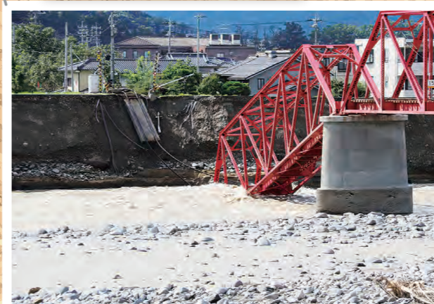
令和元年10月 橋梁崩落直後の様子
