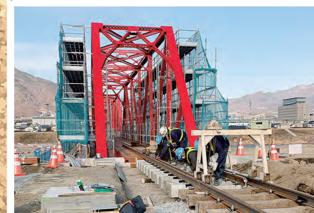
令和3年2月 線路敷設の様子
