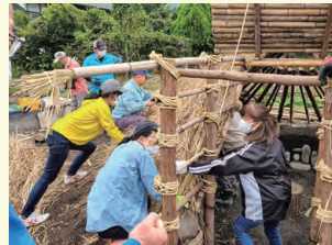
建設中の竪穴住居の様子
