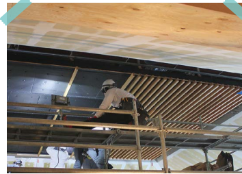
▲天井ルーバーの設置作業
