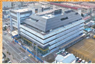
新本庁舎建設の様子
