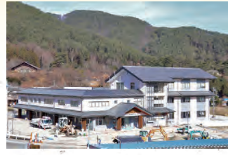
武石地域総合センター建設の様子
