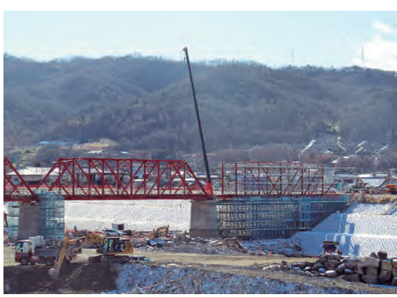
別所線千曲川橋梁復旧工事の様子
