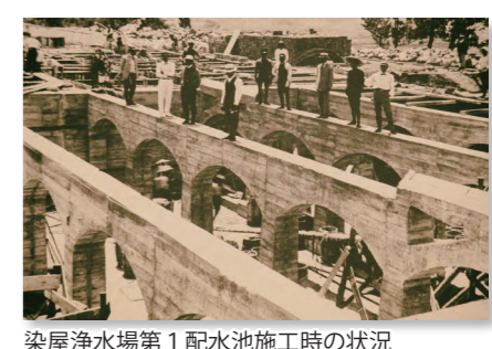
染屋浄水場第1配水池施工時の状況
