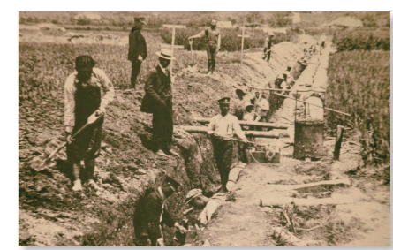
導水管施工時の状況
