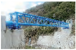
16 新設された土合水管橋
