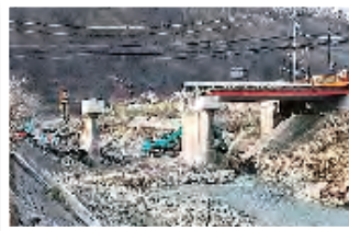
12 復旧 工事中の内村橋
