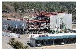
14 建設が進む武石地域総合センター
