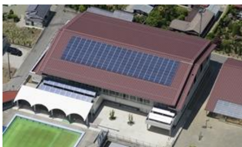
太陽光パネル
