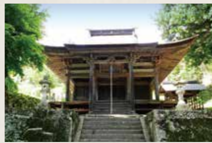
法住寺虚空蔵堂(附)厨子(重文) 大正11年4月13日指定 依田窪地区最古の建造物。室町時代に建てられました。入母屋造の長く伸びた軒は、虚空蔵堂の特徴の一つです。同時期に造られた厨子も入母屋造で造られています。
