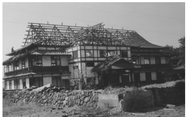
解体中の公会堂（昭和37年）
