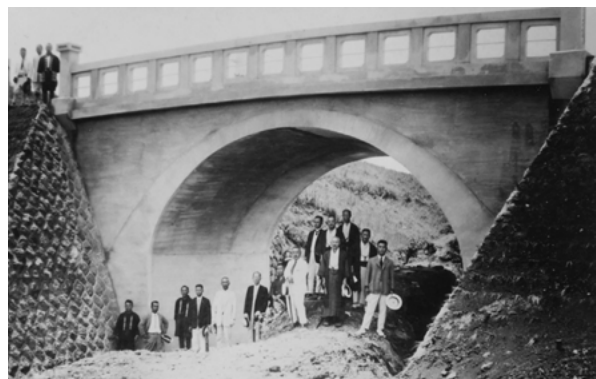
二の丸西虎口・小泉橋の整備（昭和 2 年）
