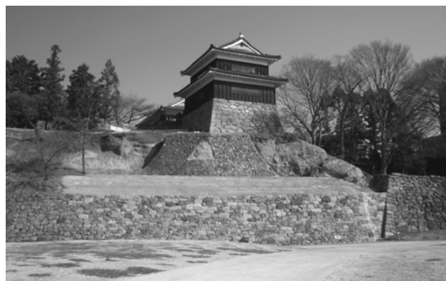
本丸南櫓下尼ヶ淵石垣解体修復事業
