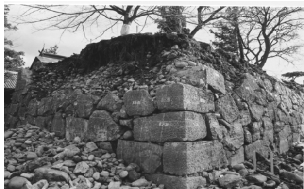
本丸西虎口石垣解体修復事業
