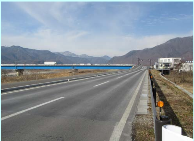
【市道上田橋中島線(基幹:道路事業)】
