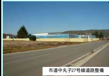
市道中丸子27号線道路整備
