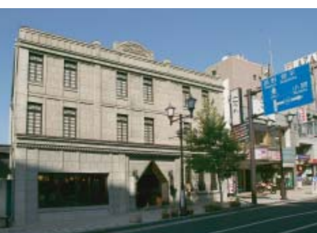
明治から大正初期に建てられたという、木造洋館の店舗
