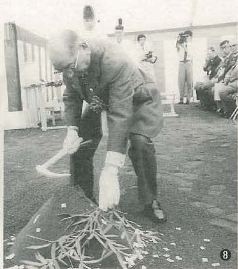
建設予定地の土塩尻中之島地籍で行われた起工式、くわ入れをする永野市長
