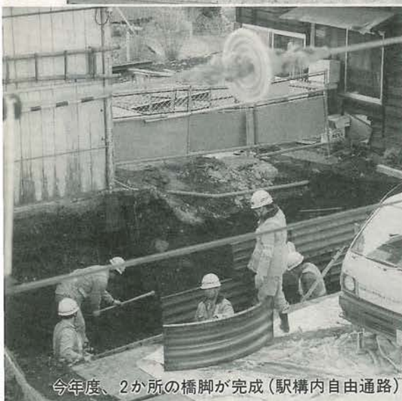
上田駅構内 工事が始まっている
