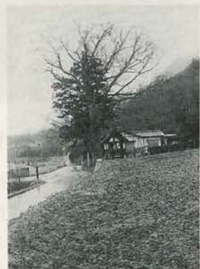
「ふれあいの里」整備では、竜光院付近に物産館を建設
